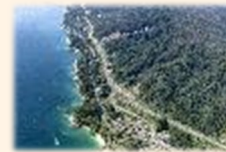
三陸沿岸道路(岩手県山田町)
